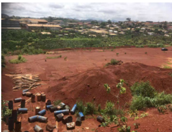
图2 从山坡上俯瞰南部工业园，远处是与民房混杂在一起的厂房，近处是一块刚刚平整好准备开工的场地。
